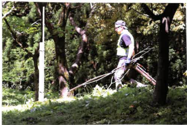
立ち枯れ枝、養生杭(不要な)の始末
