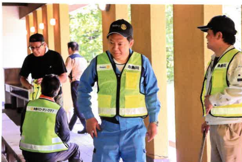
本日も安全作業第一で 無事に作業が終了 皆さんご大変苦勞様でした！
